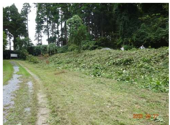
進入路付近土手の草刈完了
