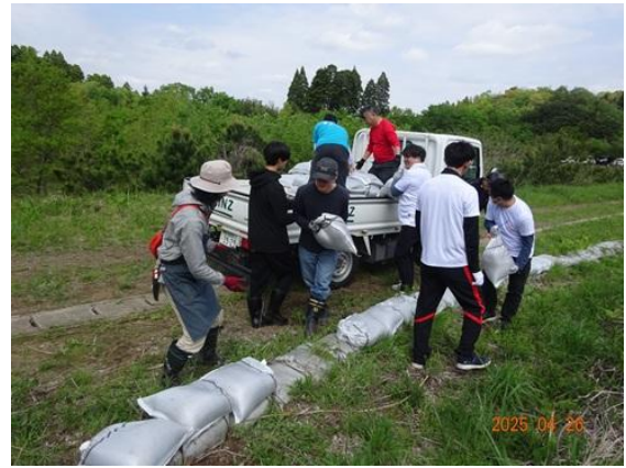
崖崩れ対策のための土嚢積み
