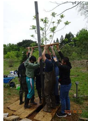
塩ビ管に杭を通し持ち上げる
