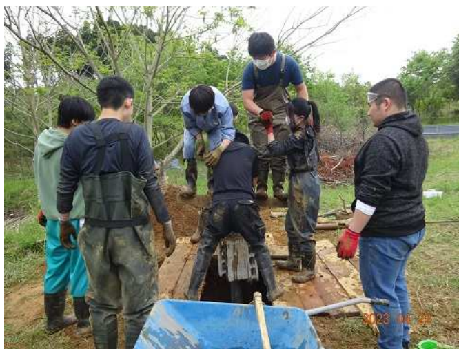
バランスをとりながら体重をかけてパイプを埋め込む
