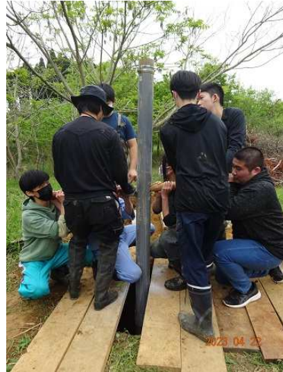
塩ビ管に杭を通し持ち上げる
