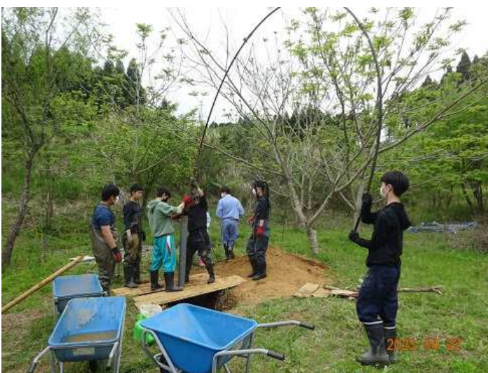
6m 底の弁と先端部分の取り出し作業
