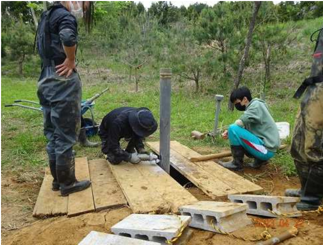
電動カッターで塩ビ管に穴をあける
