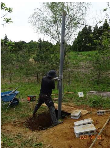
電動カッターで 2m 部分を切断
